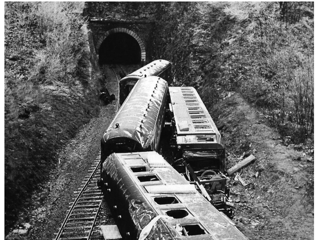
L'entrée du tunnel de la Nuville.
