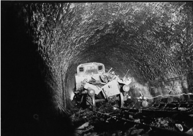
Les locomotives à l'intérieur du tunnel.
